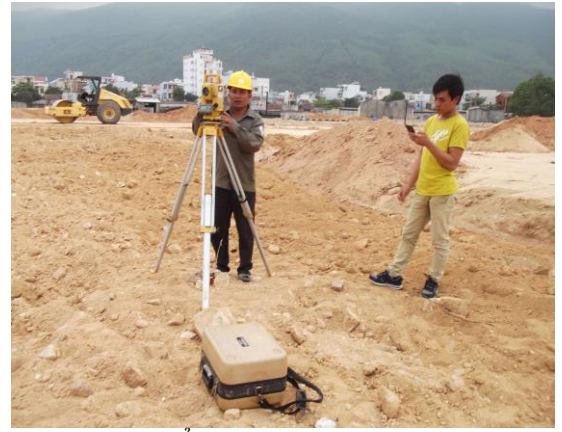
Công tác định vị và hoàn công vị trí điểm khoan
