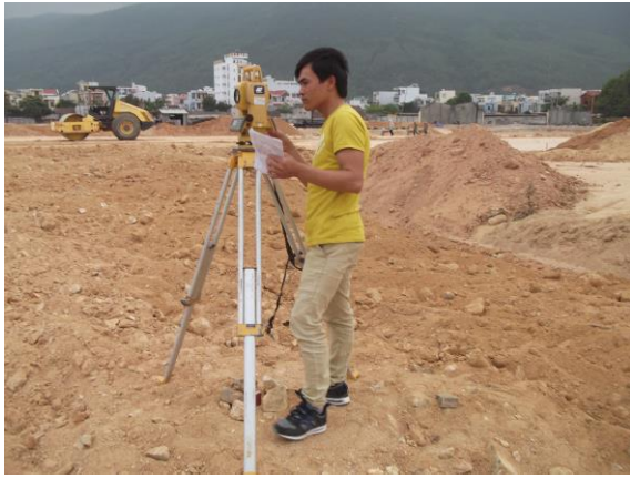
Công tác định vị và hoàn công vị trí điểm khoan
