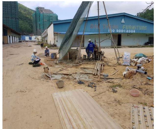
Đo điện trở suất – Đ6
