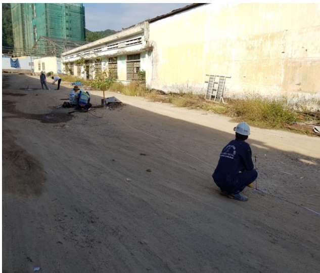
Đo điện trở suất – Đ7
