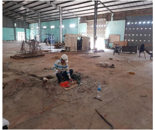
Đo điện trở suất – Đ4
