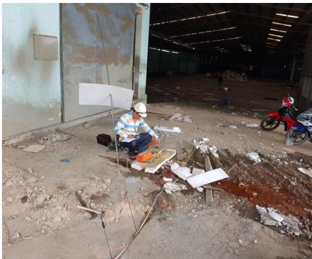
Đo điện trở suất - Đ1
