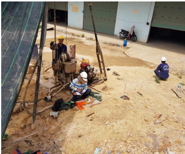
Đo điện trở suất – Đ5
