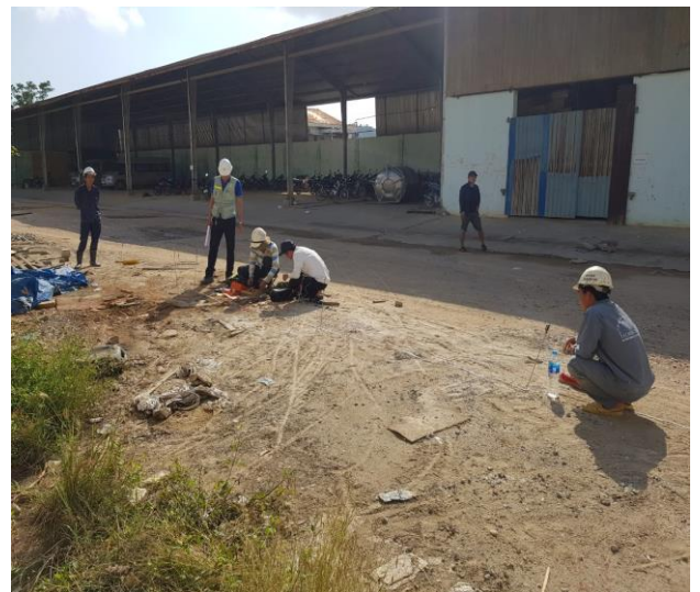
Đo điện trở suất – Đ8
