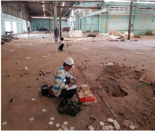
Đo điện trở suất – Đ3
