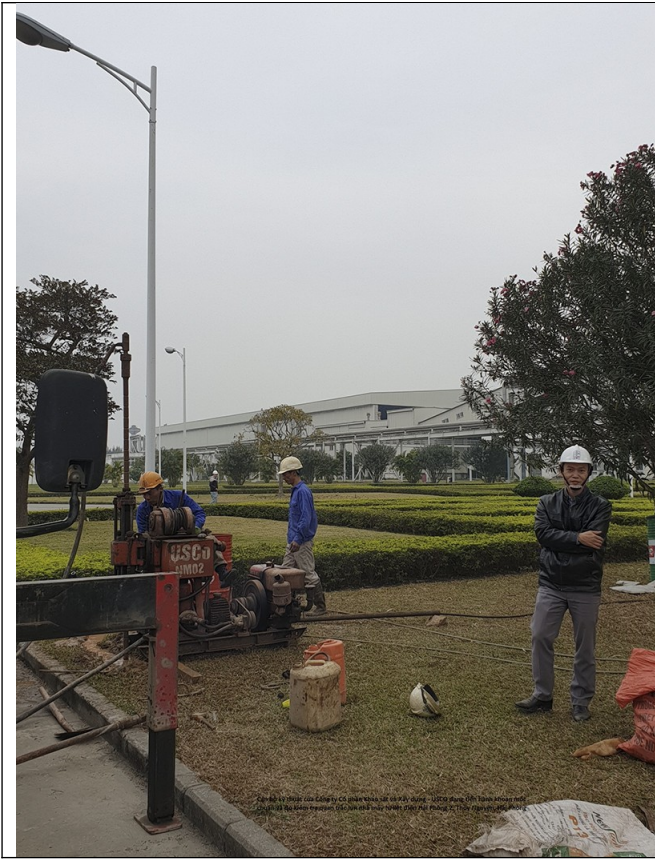
Cán bộ kỹ thuật của Công ty Cổ phần Khảo sát và Xây dựng - USCo đang tiến hành đo kiểm tra quan trắc biến dạng lún, nghiêng nhà máy nhiệt điện Hải Phòng 2, tại Thủy Nguyên, Hải Phòng.
