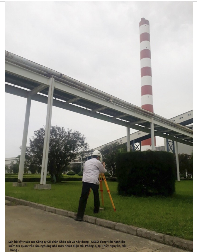
Cán bộ Công ty Cổ phần Khảo sát và Xây dựng - USCo tiến hành đo kiểm tra quan trắc biến dạng lún, nghiêng nhà máy nhiệt điện Hải Phòng 2, tại Thủy Nguyên, Hải Phòng.
