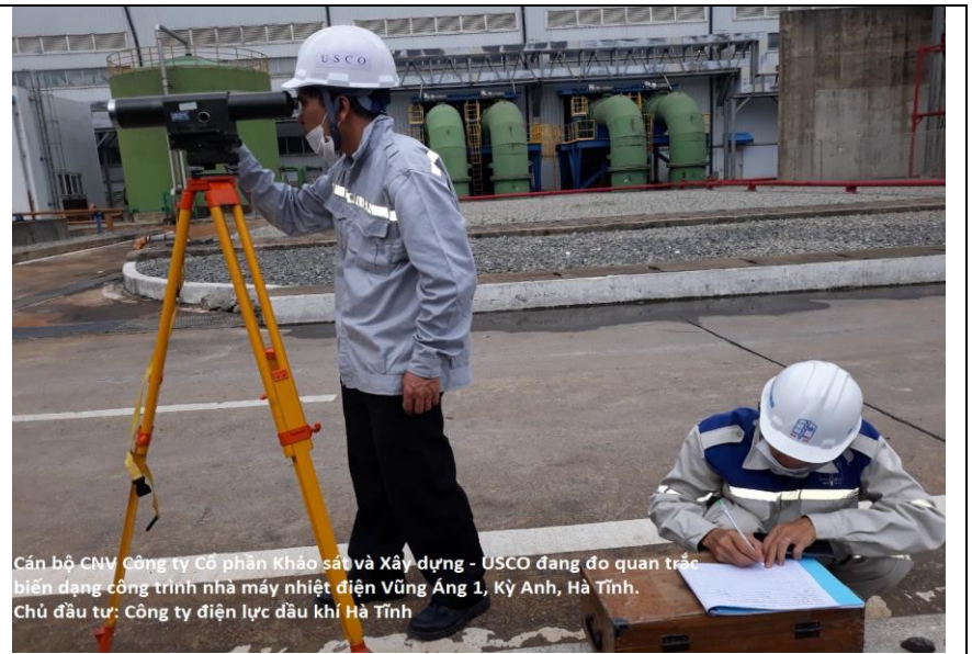
Cán bộ CNV Công ty Cổ phần Khảo sát và Xây dựng - USCO đang đo quan trắc biến dạng nhà máy nhiệt điện Vũng Áng 1, Kỳ Anh, Hà Tĩnh. Chủ đầu tư: Công ty điện lực dầu khí Hà Tĩnh.
